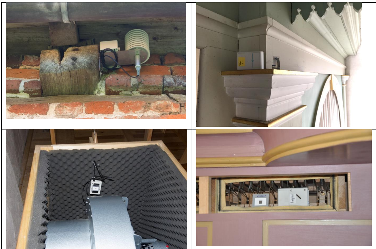
Abb. 18: Einbau von Klimasensoren, oben links: Außensensor Mariendrebber, oben rechts: Sensor im Kirchenraum (Kanzel) Belum, unten links: Sensor im Motorkasten Belum, unten rechts: Sensor in Windlade Belum
